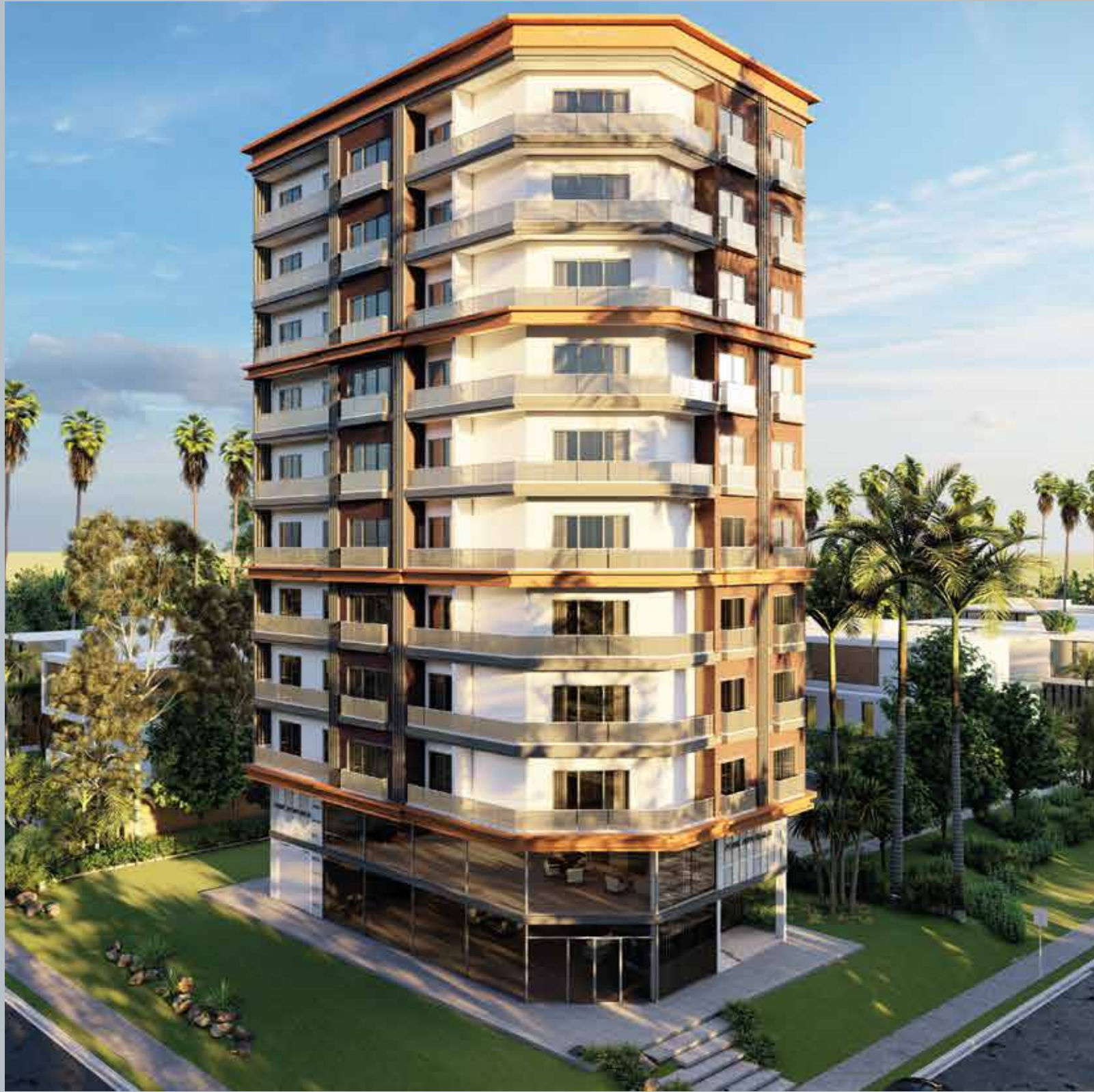
Projet en cours.
